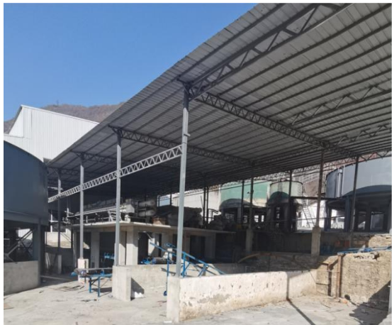
精矿车间 (在建)
