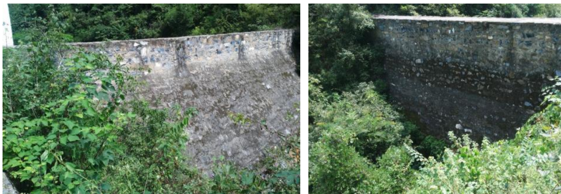
尾矿库上游拦洪坝现状
