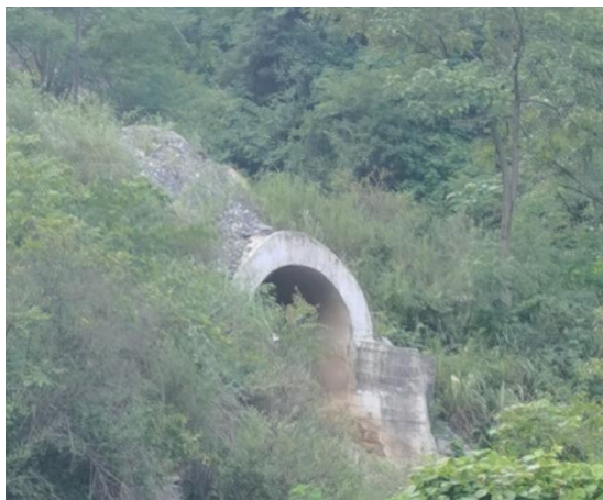
排洪隧洞出口
