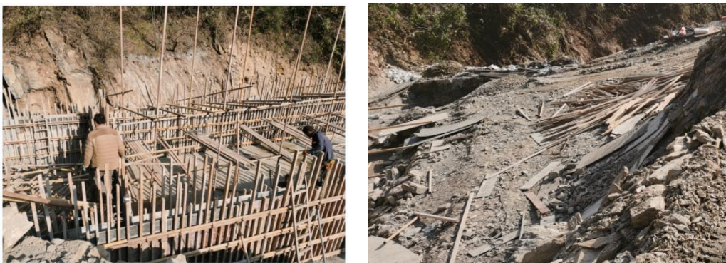
图 6.2.6-1 尾矿库回水池现场照片
