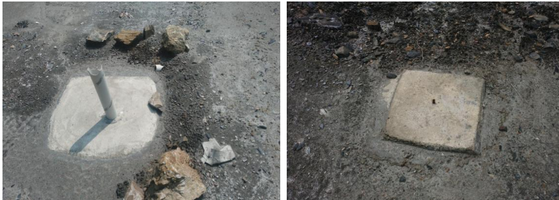
浸润线观测孔及坝体变形观测点
