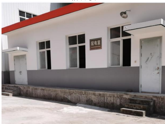
破碎、筛分车间配电室
