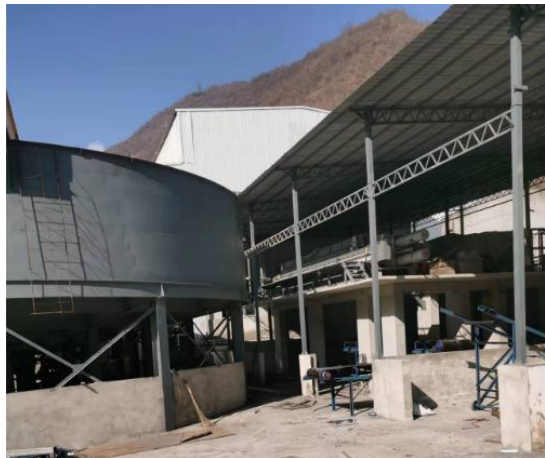
尾矿压滤车间 (在建)
