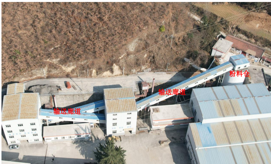
选厂输送廊道、粉矿仓封闭情况
