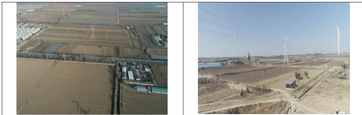
图 4.2-1 工程沿线典型地貌现状照片
