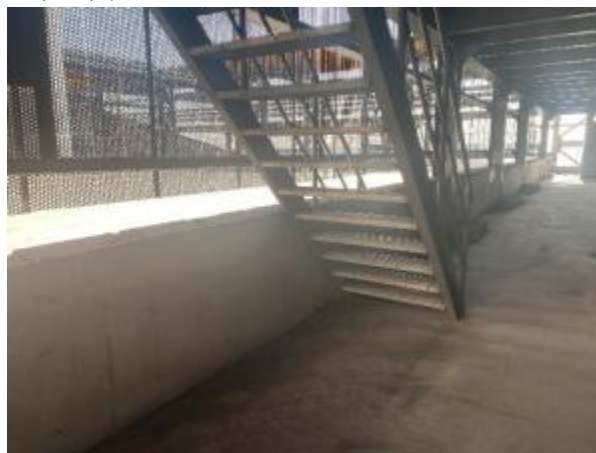
兰炭装置区围堰
