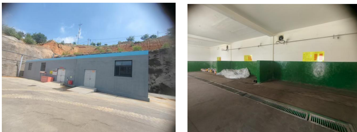
图 8.2-3 现有危废贮存库
