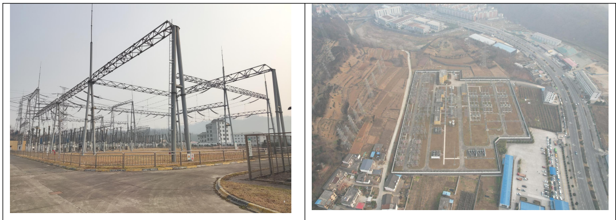
图 4.2-1 鹿城 330kV 变电站站址现状
