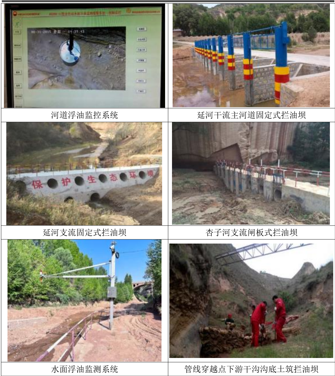
图 7.2.7-3 现有环境风险防范设施现场照片
