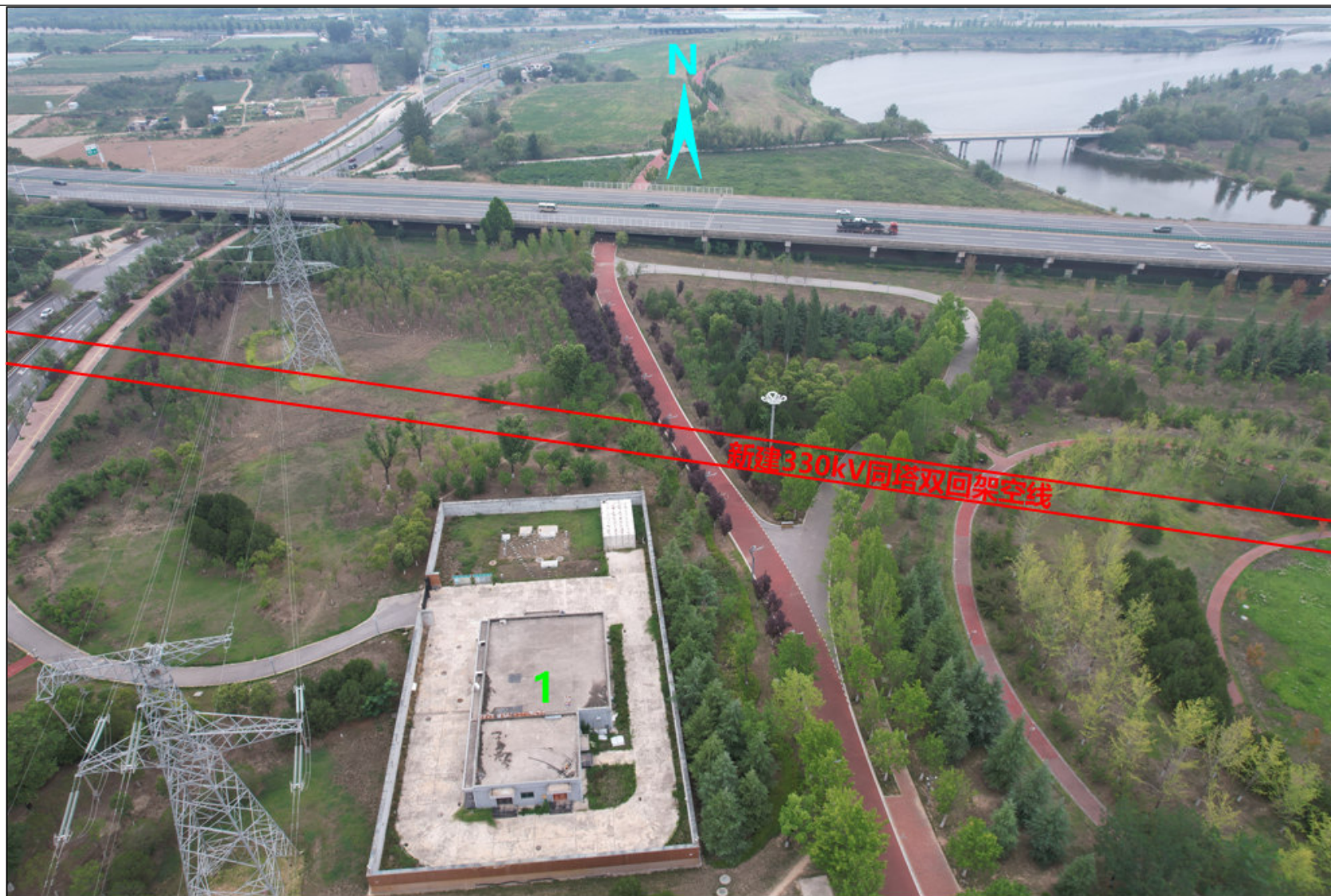
2 沔河公园管护办公楼现状照片
