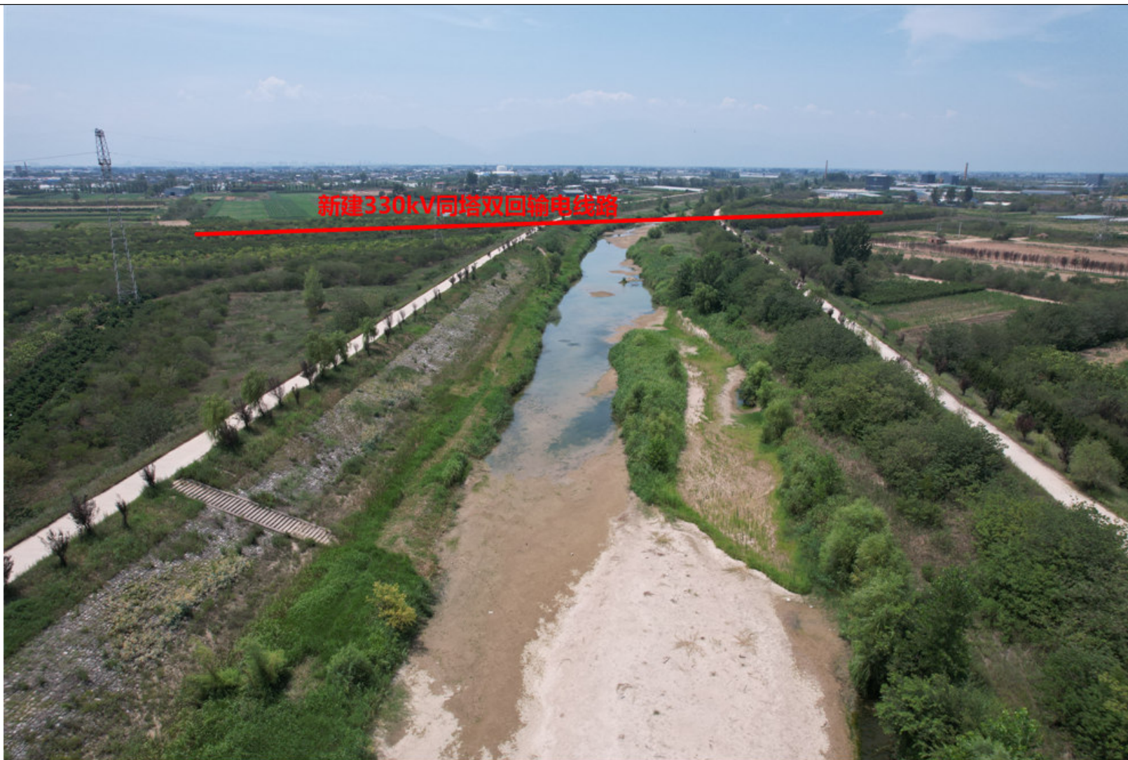
2 输电线路经过户县涝峪河湿地（生态保护红线）处现状照片
