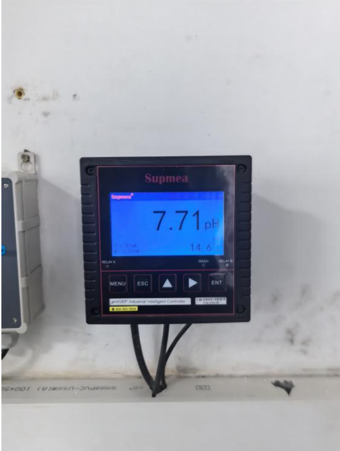
矿井水处理站污水在线监测设备
