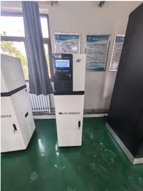
矿井水处理站污水在线监测设备
