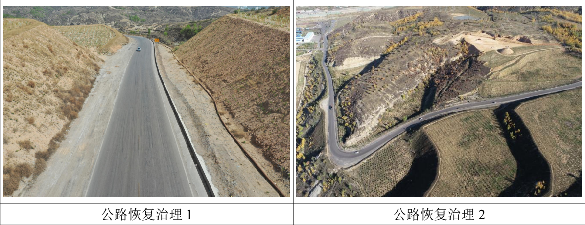
图 3.1-15 公路恢复治理图片
