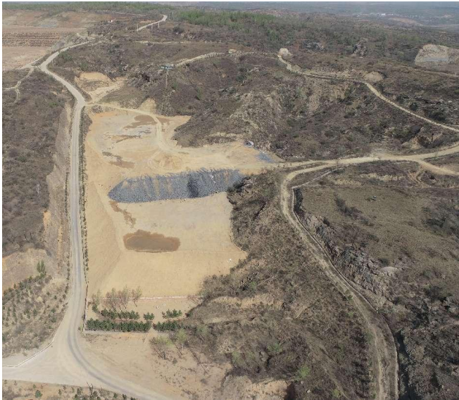
图 3.1-12b 东川煤矿排矸场覆土（待绿化）照片
