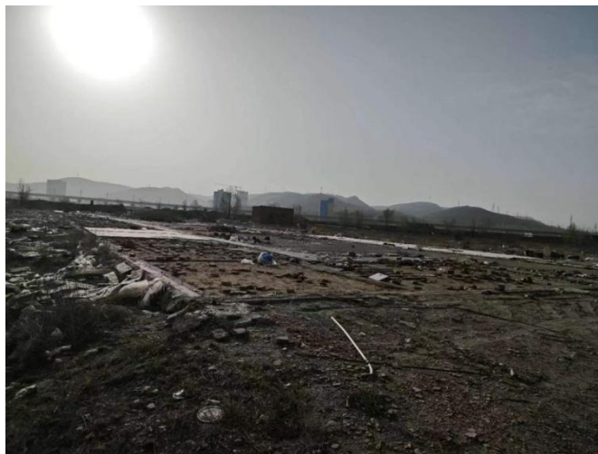
水井渠煤矿工队临时住房活动板房已拆除（二盘区东南角）
