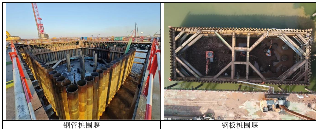
图 3.1-2 钢围堰施工示例图
