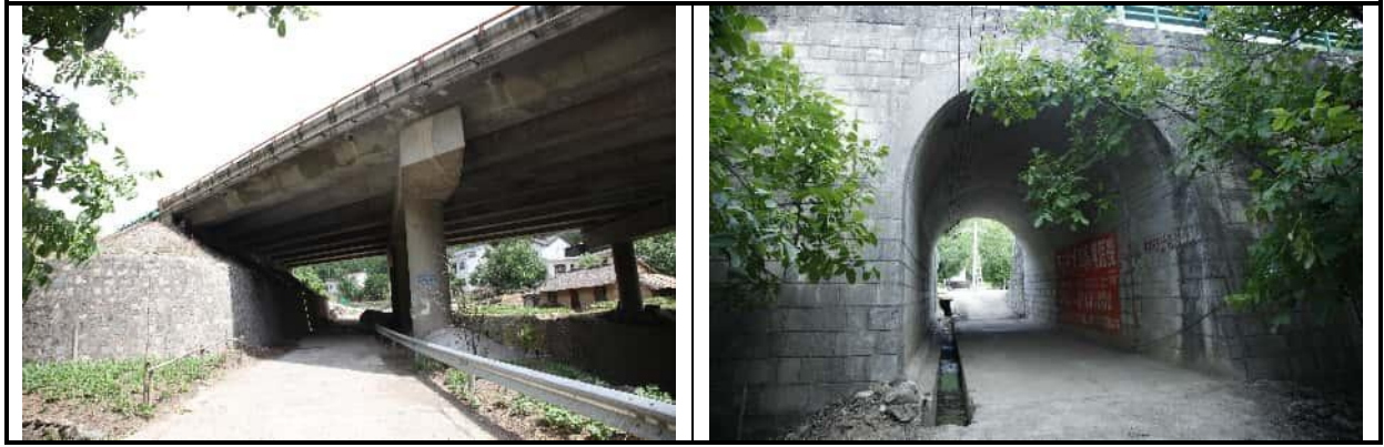
图 5-2 现有施工道路照片
