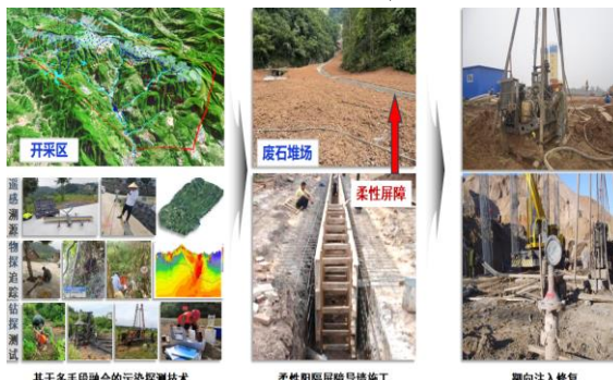
图6 污染探测、柔性屏障、靶向注入施工现场
