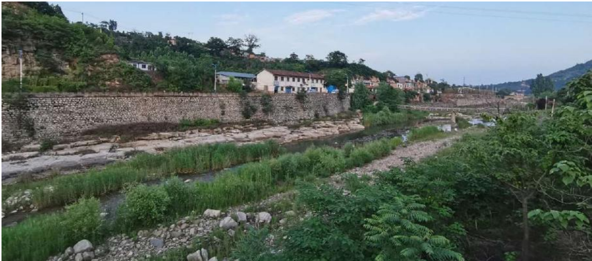
图 2.12-20 濠水河穿越点地势空间和生态现状实景
