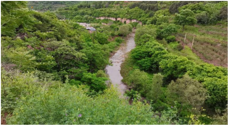
图 2.12-16 盘河穿越点地势空间和生态现状实景
