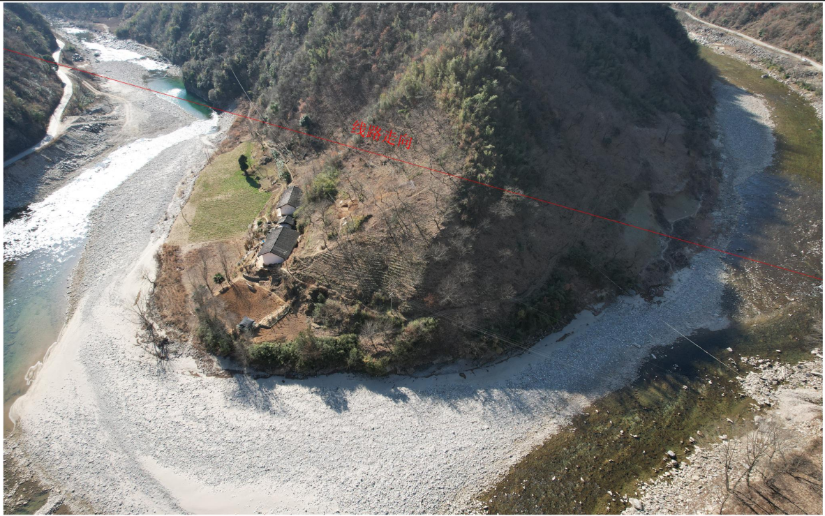
黄金村跨越旬河处（镜头朝向西南）
