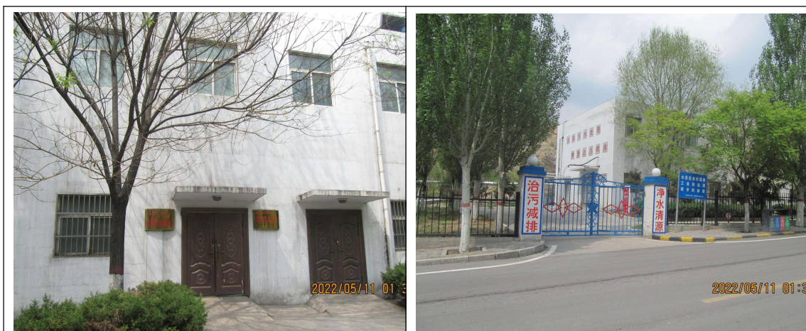
图 4.6.1-6 生活污水处理站现场照片
