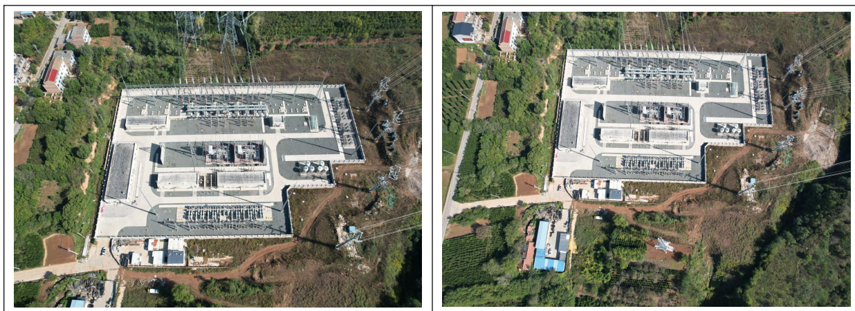
图 4.2-1 美玉 330kV 变电站站址现状
