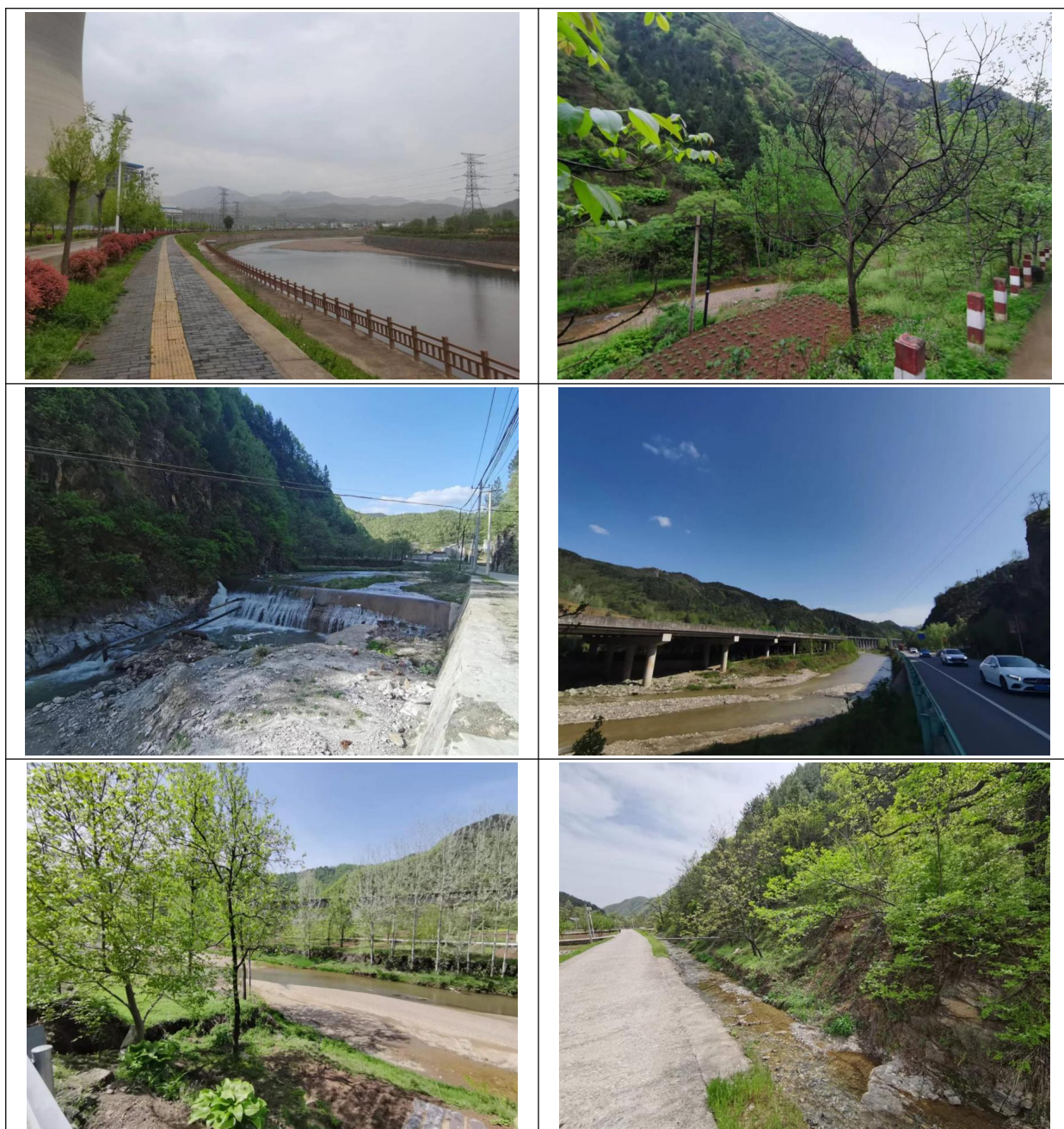
图 4.2-2 输电线路沿线现状
