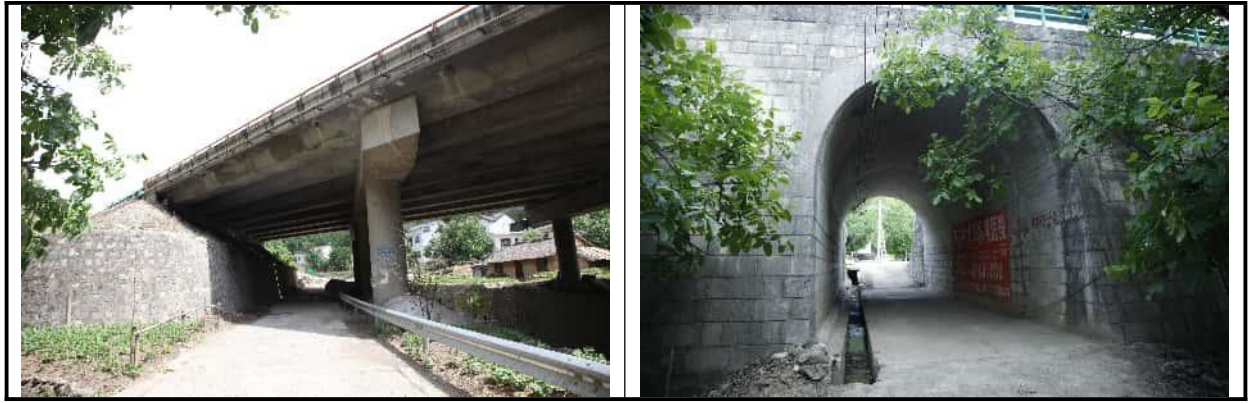
图 5.1-2 现有施工道路照片
