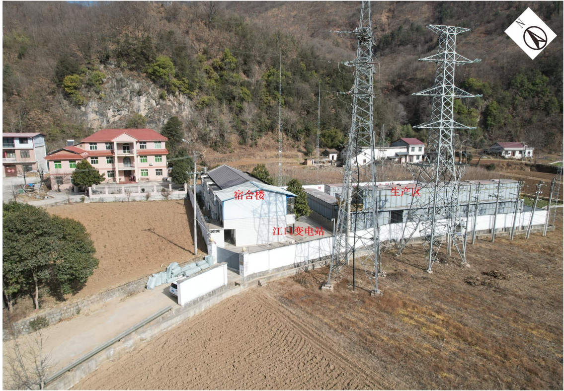
图 2-2 江口 110kV 变电站站址现状照片（航拍，镜头朝向北）
