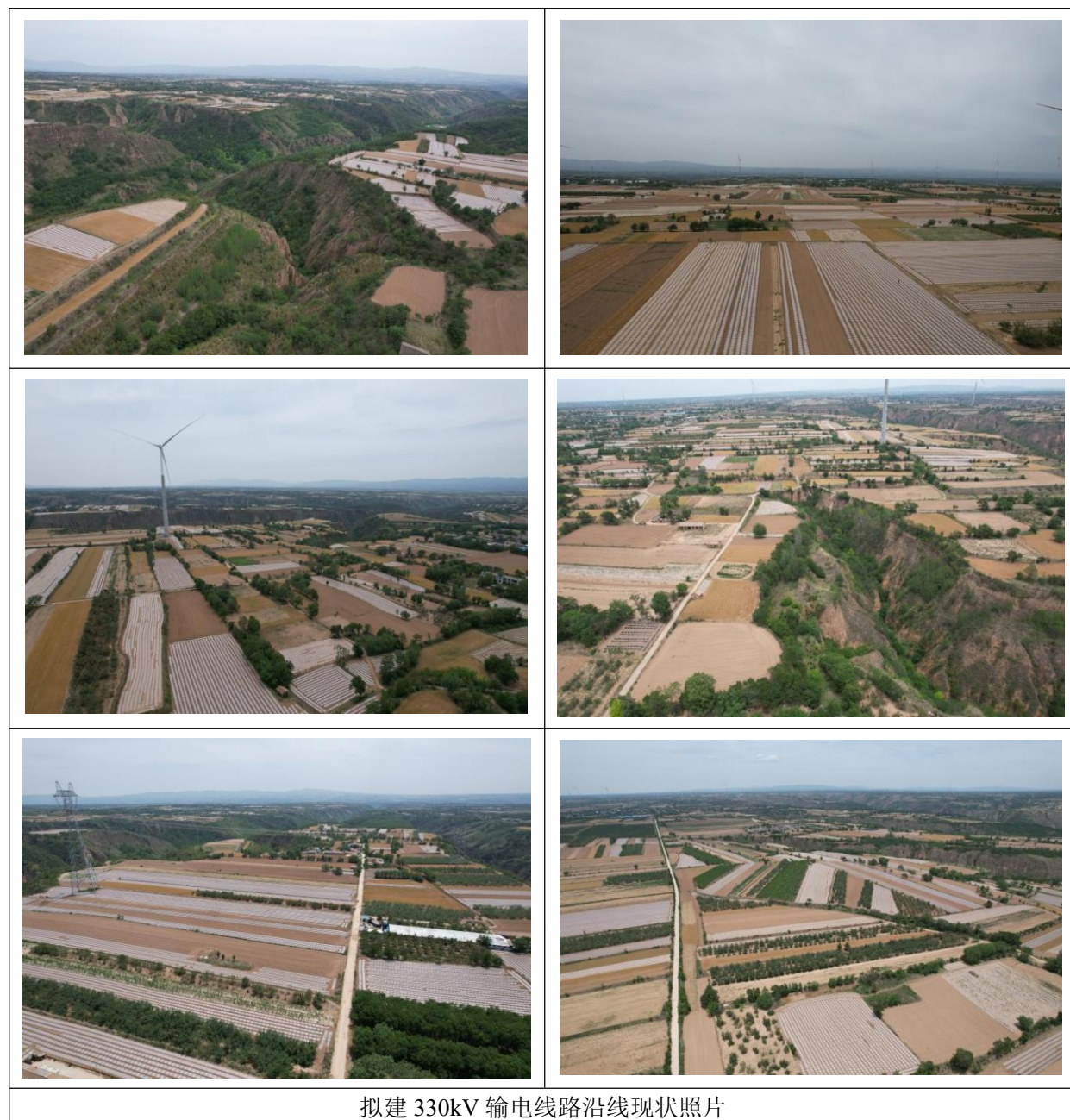
图 4.5-1 项目所在区域现状照片
