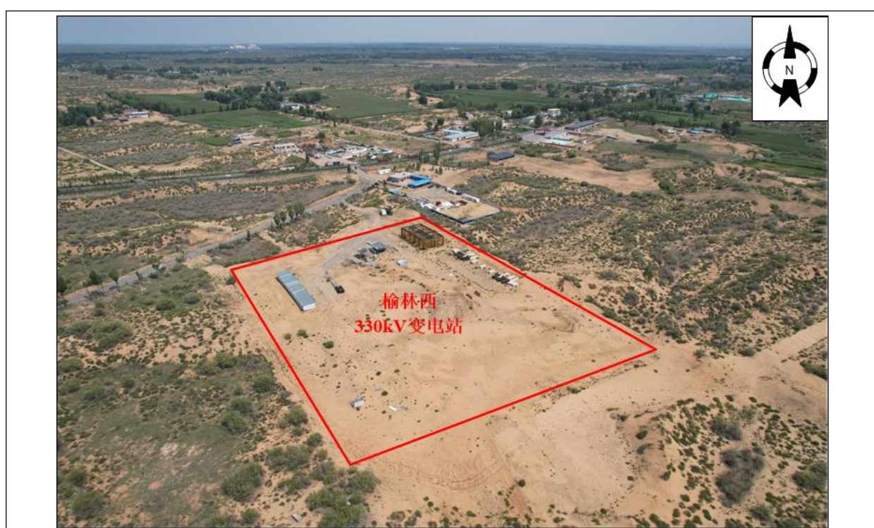
图 3.1-1 榆林西 330kV 变电站站址现状
