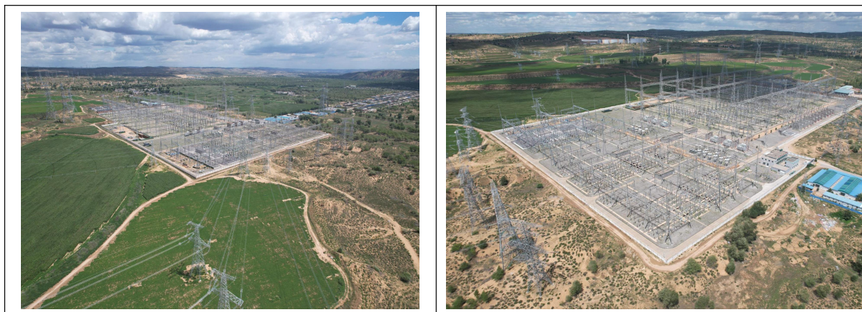
图 4.2-2 榆横 750kV 变电站站址现状
