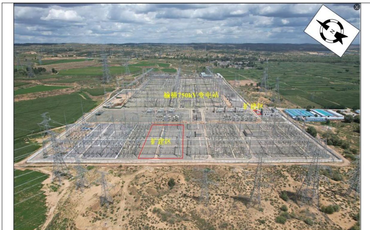
图 3.1-3 榆横 750kV 变电站站址现状
