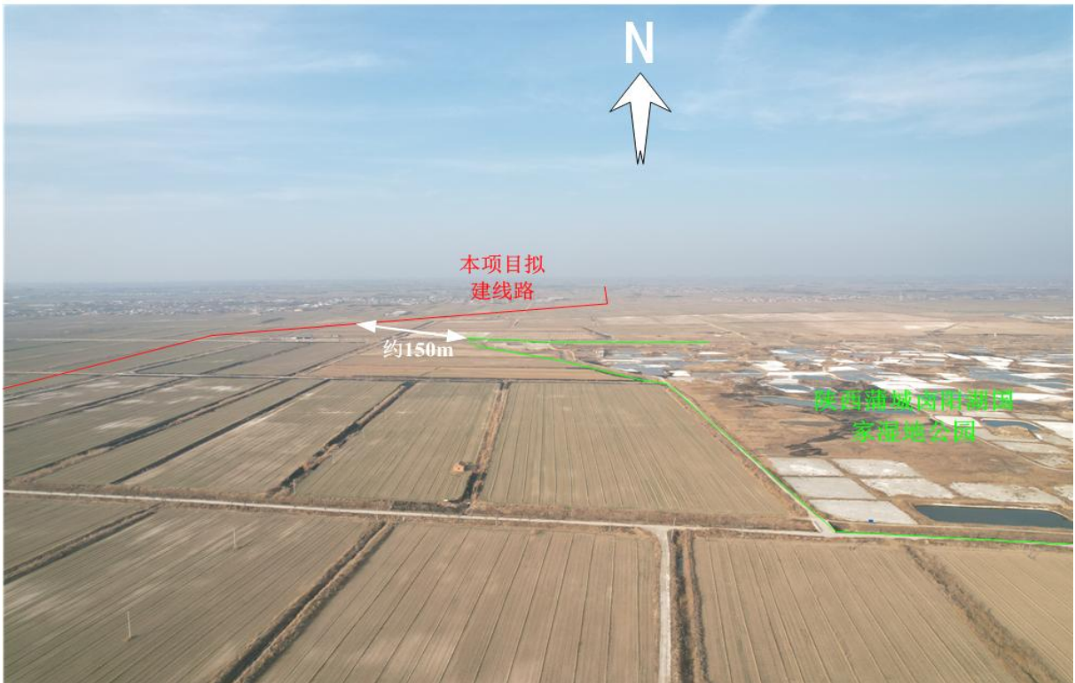
图 2.5-3 项目与陕西蒲城卤阳湖国家湿地公园（候鸟重要栖息地）处现状照片
