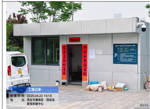
捷东产业园警卫室
