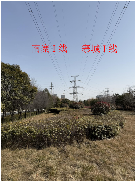
图 3.1-1 利旧段南寨 I 线线路现状
