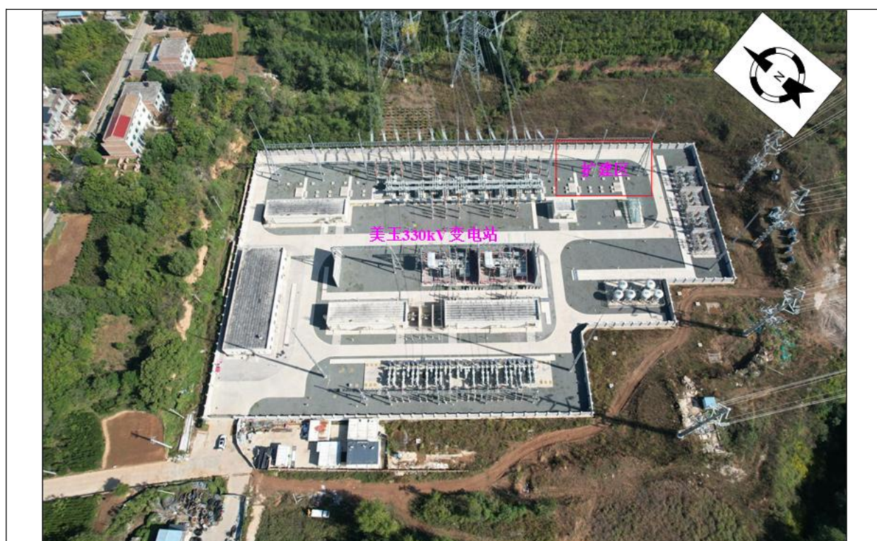
图 3.1-1 美玉 330kV 变电站站址现状
