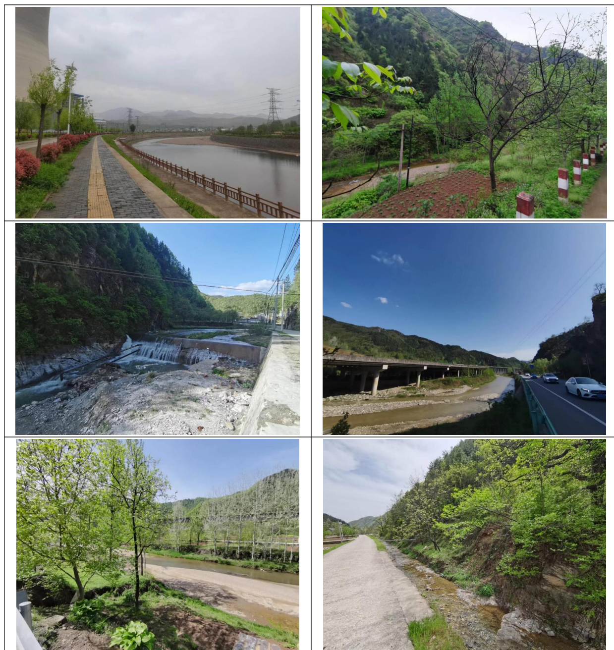
图 4.2-2 输电线路沿线现状
