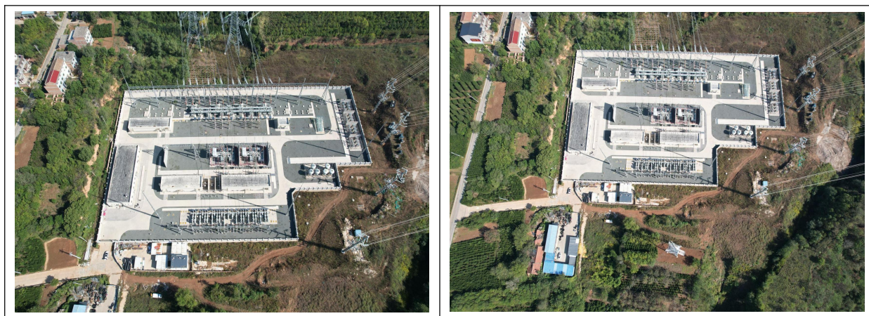
图 4.2-1 美玉 330kV 变电站站址现状
