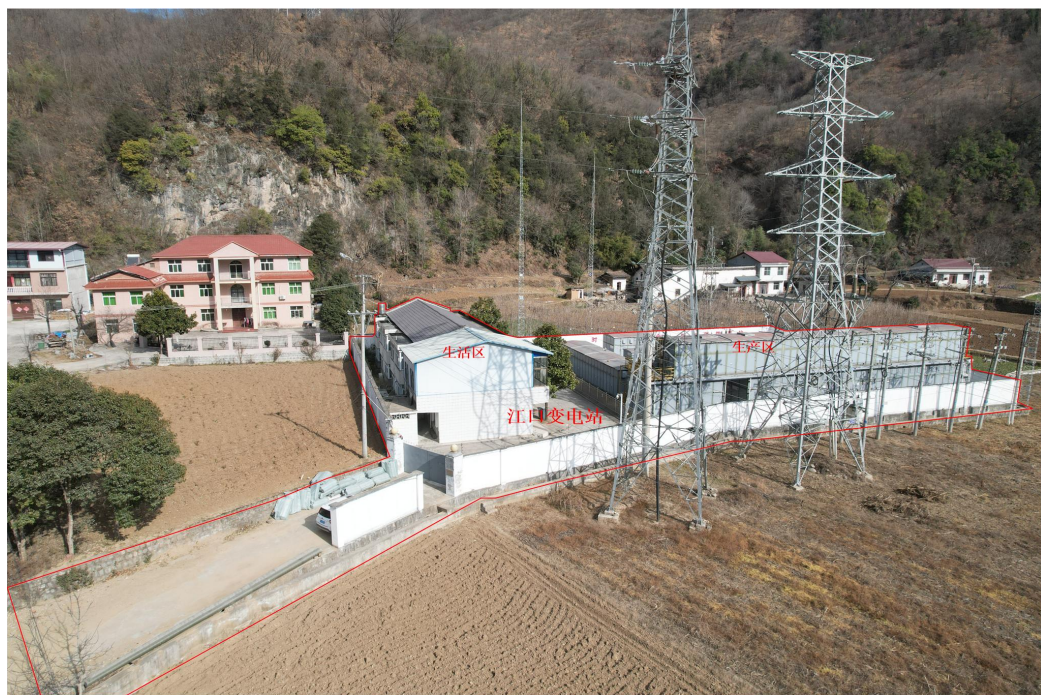
图 2-2 江口 110kV 变电站站址现状照片（航拍，镜像北）
