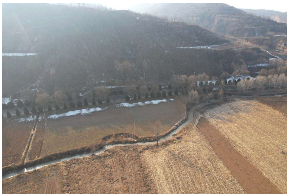
图 4.2-3 本项目输电线路经过白水河处现状照片
