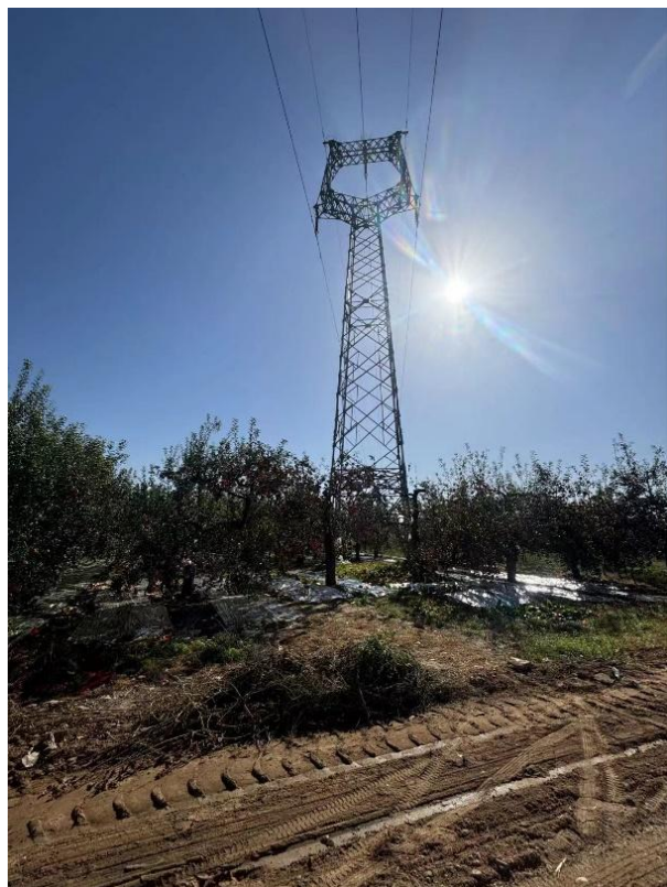
延安市富县清涧村附近塔基
