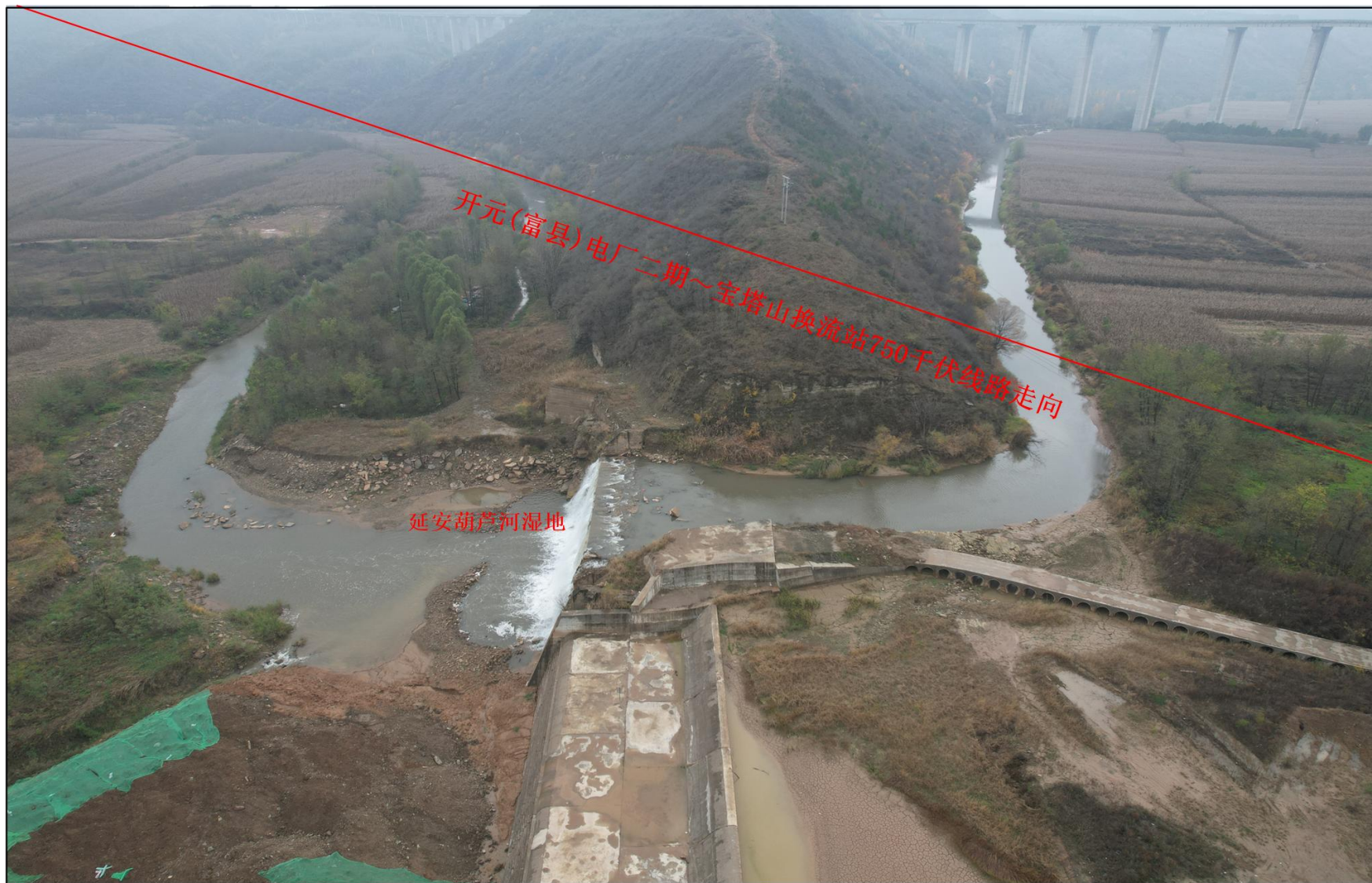
图 2.5-7 项目与延安葫芦河湿地位置关系照片（镜像南）
