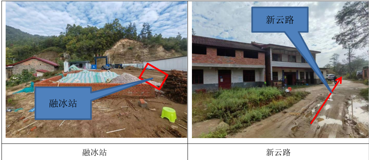
图 3.1-3 融冰站及融冰线路占用新云路现状照片
