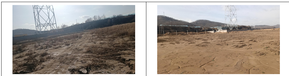
图 5.6-1 项目铺设地网的临时占地范围现状照片
