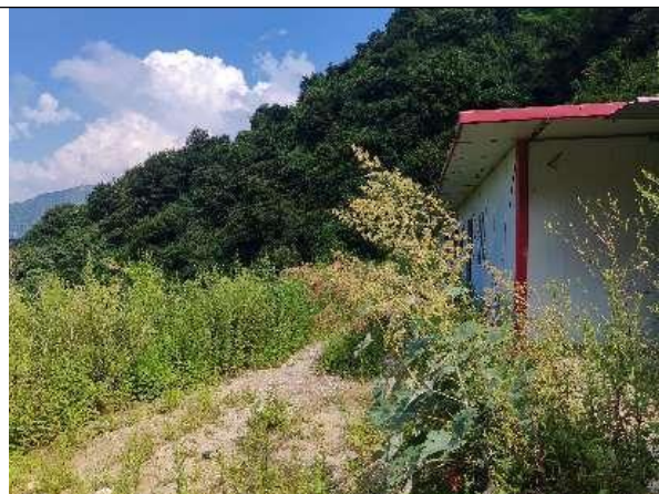
杨树沟一坑现状 (1)
