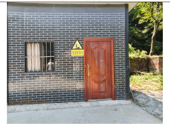
818 一坑口工业场地危险废物贮存设施
