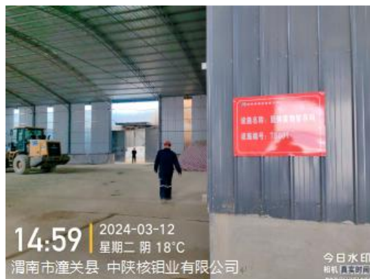
钼铁炉渣暂存库
