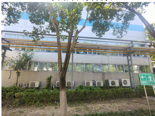
车间外东侧现状
