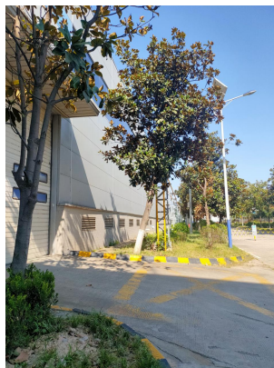
车间外南侧现状
