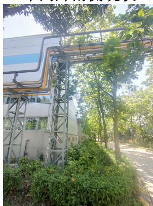
车间外北侧现状
