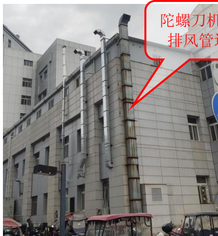
图 10-12 陀螺刀机房排风管道照片及通风机参数
