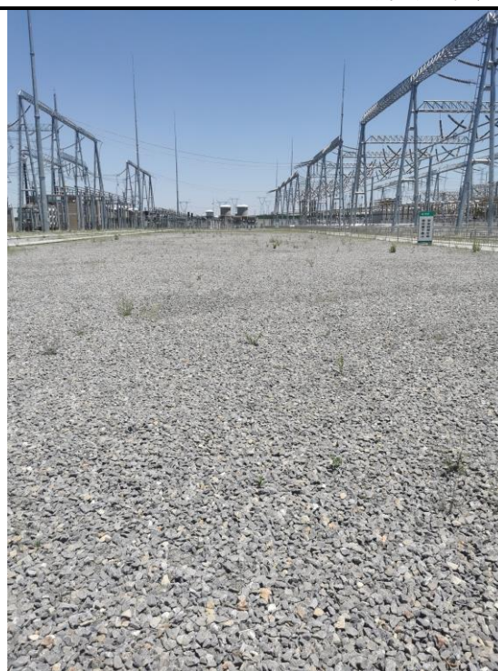
站内碎石铺设
