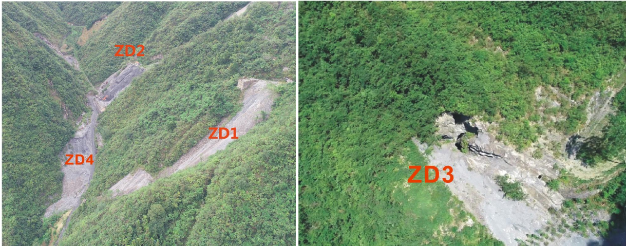
图 2.3-1 银洞沟及两侧支沟四处渣堆现状航拍图
