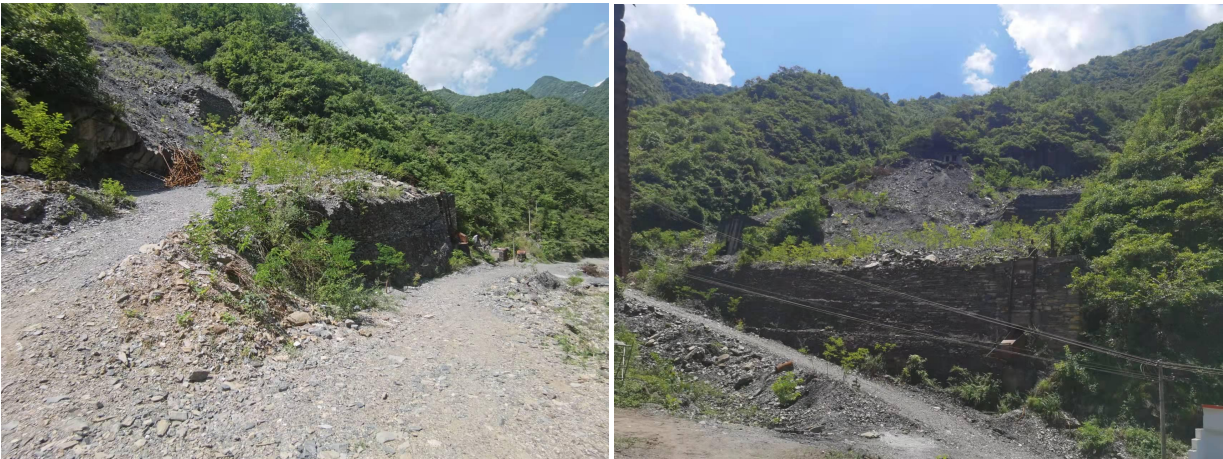
图 2.3-2 现存渣堆下部干砌石挡墙及渣堆下部植被恢复情况图组
