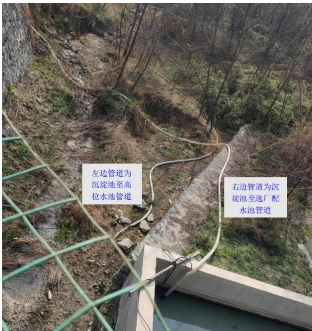
非正常工况下（选厂检修、停产期间），矿井涌水经四级沉淀池沉淀后用泵抽至高位水池，再经选厂配水池后送至选厂北侧 80m 的潼关县兴泰石料加工厂综合利用（用水协议见附件 12），潼关县兴泰石料加工厂建设年产 25 万 t 建设用碎石和砂生产项目，用水量约 300t/d，本项目正常生产时，用水水源为厂区自备水井。本项目沉淀池至兴泰排水管道现状图如下：
