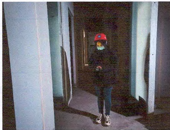
综合医院介入中心介入手术室 2 上部
