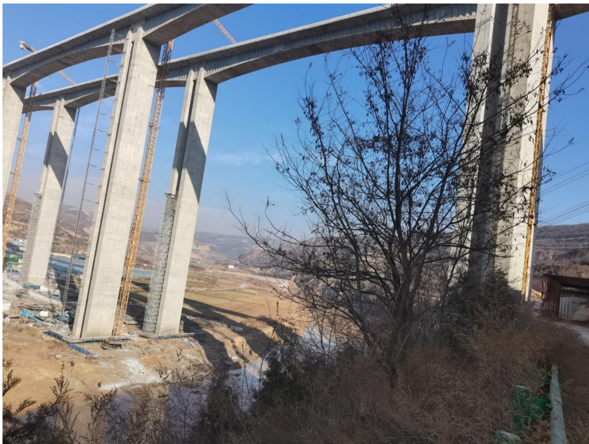
3.5-10 项目跨越陕西泾河湿地现场照片
