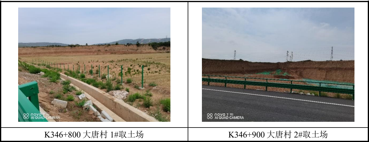
图 4.4-1 项目沿线典型取、弃土（渣）场现状
