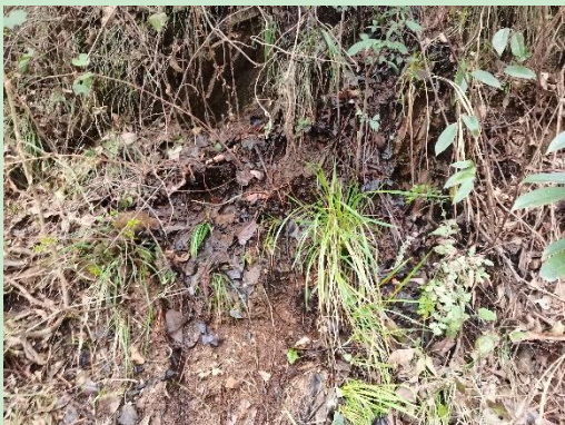
大泥沟工业场地下游山泉出水口现状
