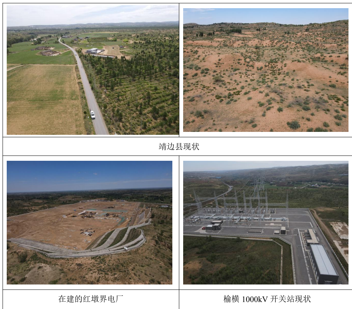
图 4.2-1 本工程沿线现状照片
