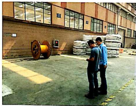
图 5 特缆分厂（加速器机房）南墙监测
