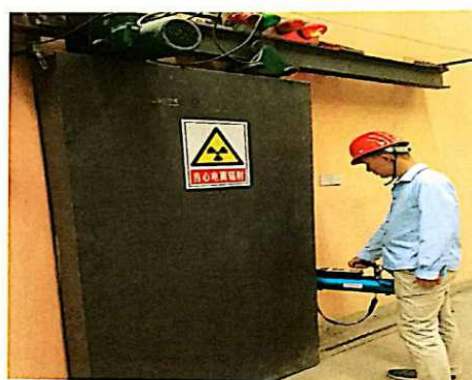
图 4 加速器机房负一层防护门监测
