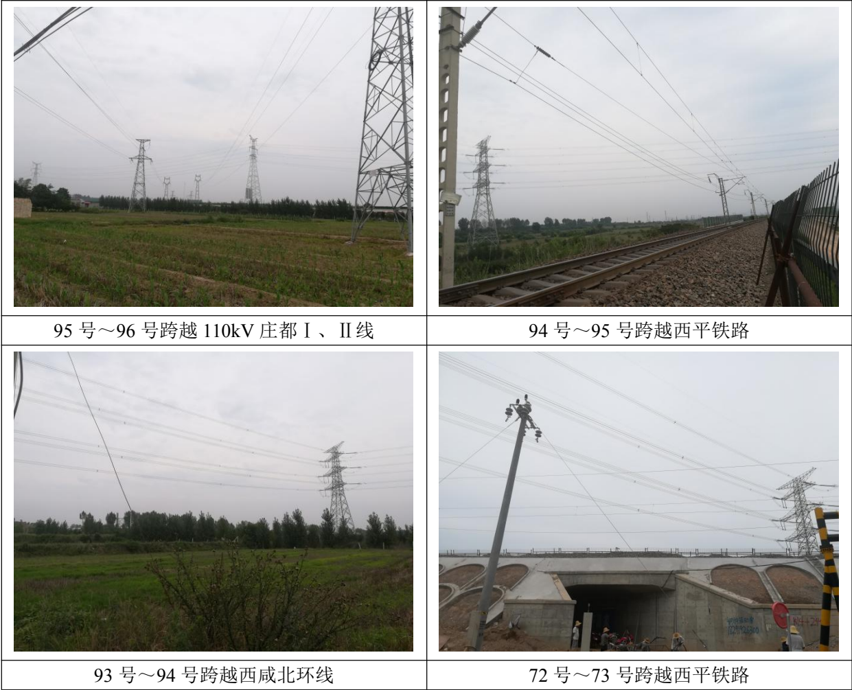
图 11.2-1 输电线路跨越铁路、公路、电力线路处照片
