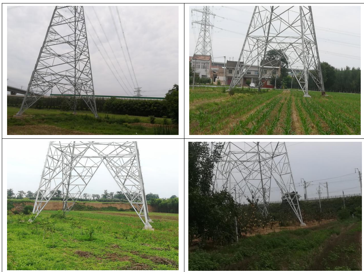
图 6.4-1 输电线路塔基绿化恢复照片
